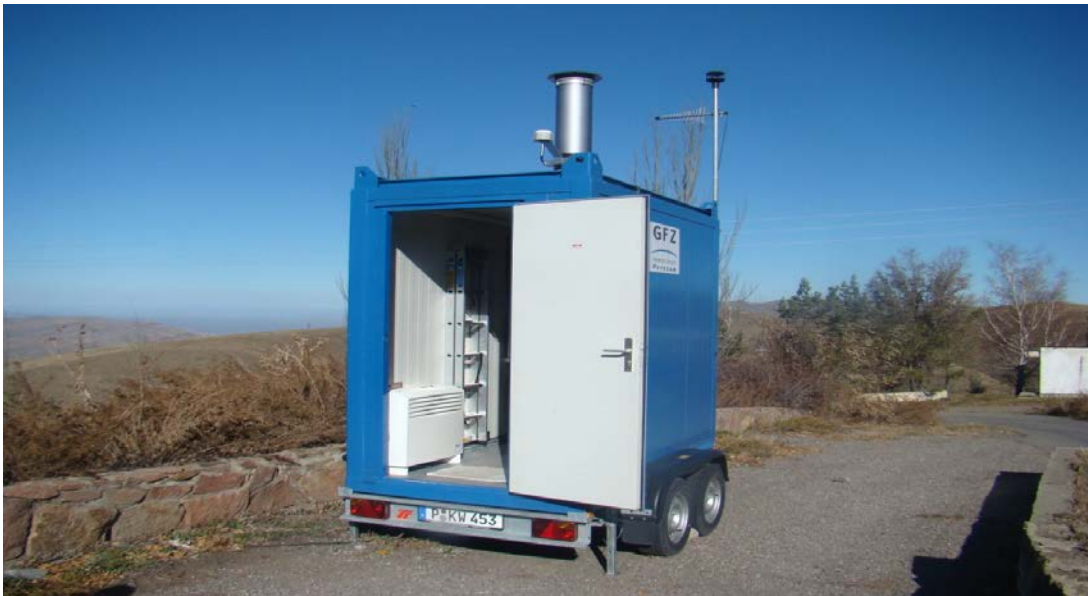
Рис. 2.1.5.1 Станция мониторинга атмосферной пыли
