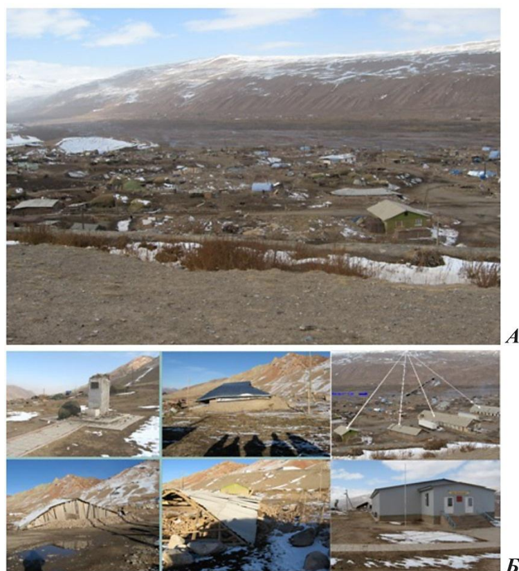
Рис. 1.4.1. Поселок Нура после землетрясения (А), типовые повреждения строений (Б) (фото Мелешо А.В.).
