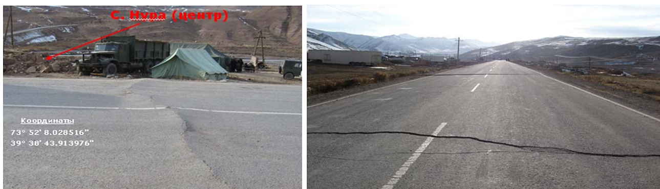
Рис. 1.4.2. Трещины (внизу) и «волны деформации» (вверху), образовавшиеся в пределах поселка Нура и его окрестностях в радиусе 2-3 км. (Фото Мелешко А.В.).
